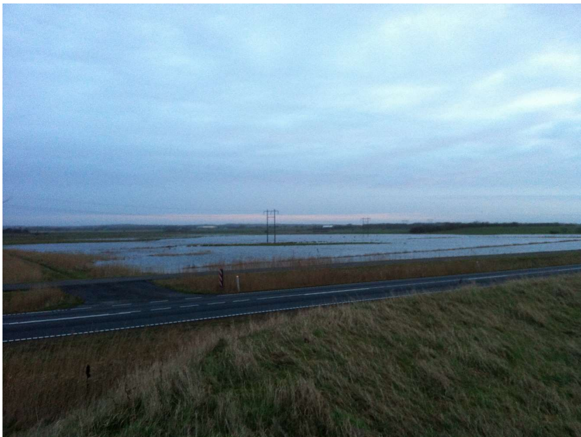
Foto: Træ elmast står i vanddækket område.
